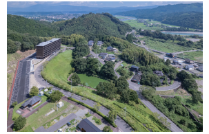
豪雨災害: 球磨村災害公営住宅エスベランサ桜峯
