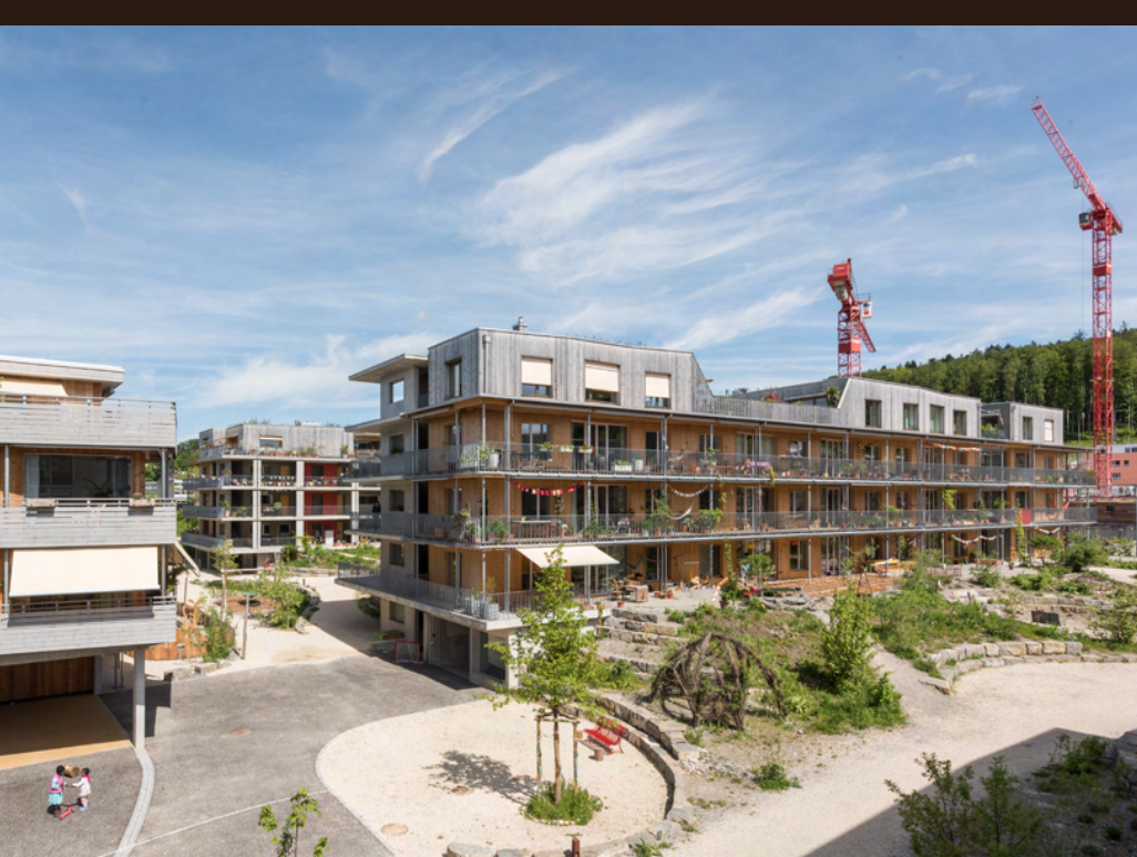
Wohnüberbauung Oberfeld, Ostermündigen 木造集合住宅(スイス・ベルン市)
